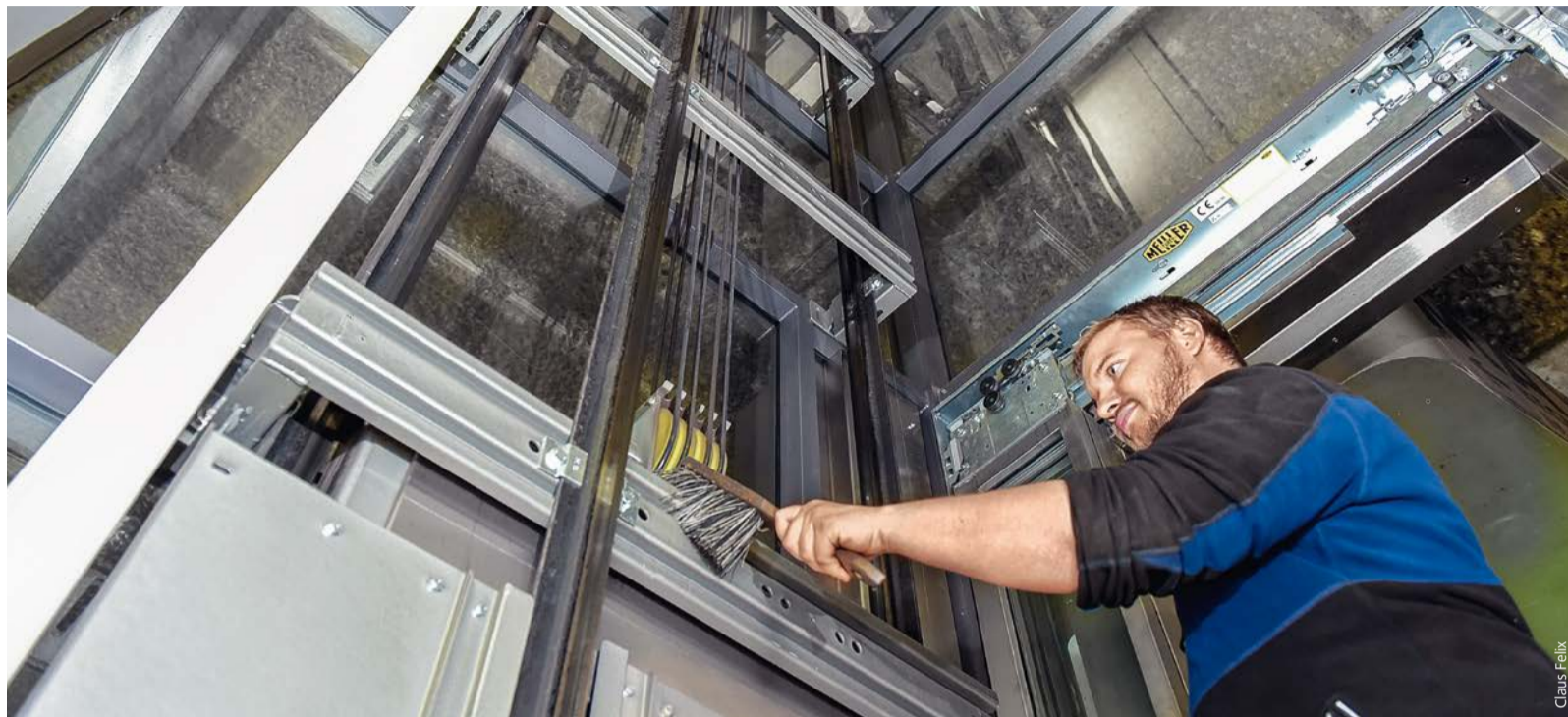
VAG-Aufzugsmonteur Jan Rupprecht wartet den Aufzug am U-Bahnhof Maximilianstraße. Stück für Stück arbeitet er sich vom Schacht aufs Dach.
