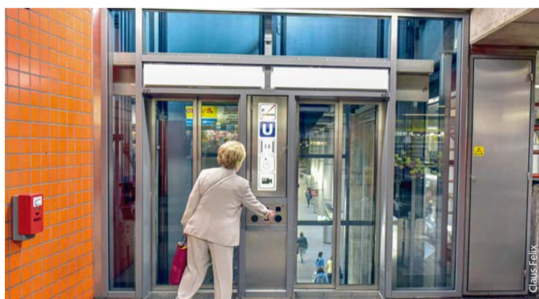
Alle Bedienelemente an den Aufzügen im VAG-Netz sind barrierearm.
