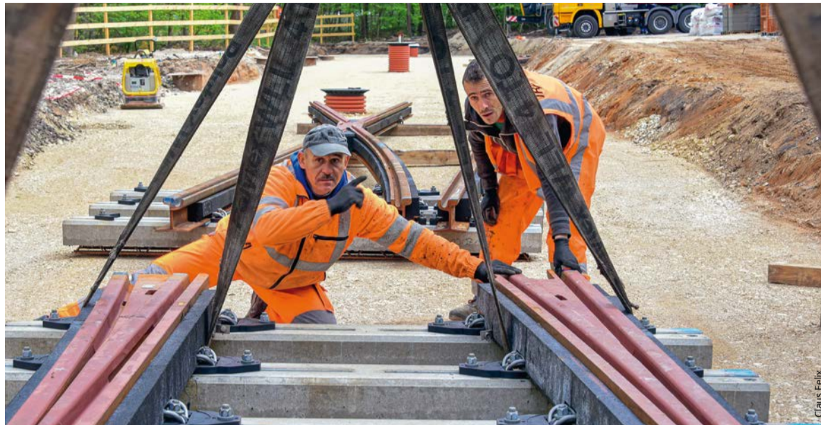
530 Meter neue Gleise wurden während der Arbeiten an der Wendeschleife am Tiergarten ins Gleisbett gehoben.
