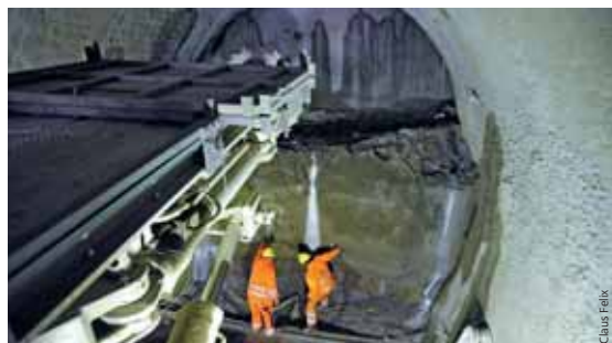
Der Bohrkopf fräst Stück für Stück den Tunnel Ulrike in den Sandstein.
