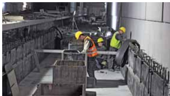
Hilfskonstruktionen bereiten den Einbau des Masse-Feder-Systems vor.
