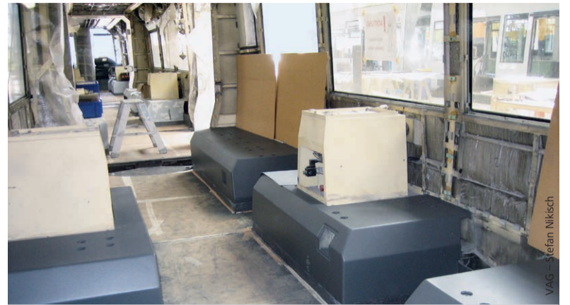
Noch ist die Straßenbahn Baustelle. 2018 fährt sie wieder.
