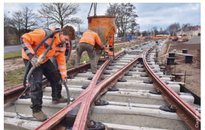
Sind die Gleise montiert, werden die Schwellen auch gleich einbetoniert.
