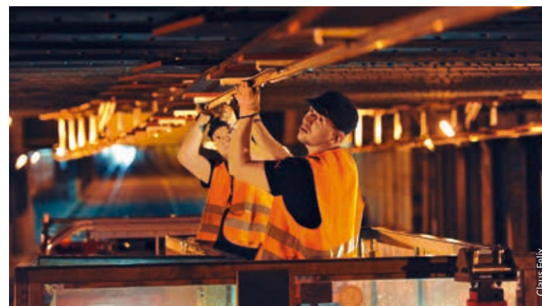
Konzentriert beheben die Oberleitungsmonteur den Schaden.
